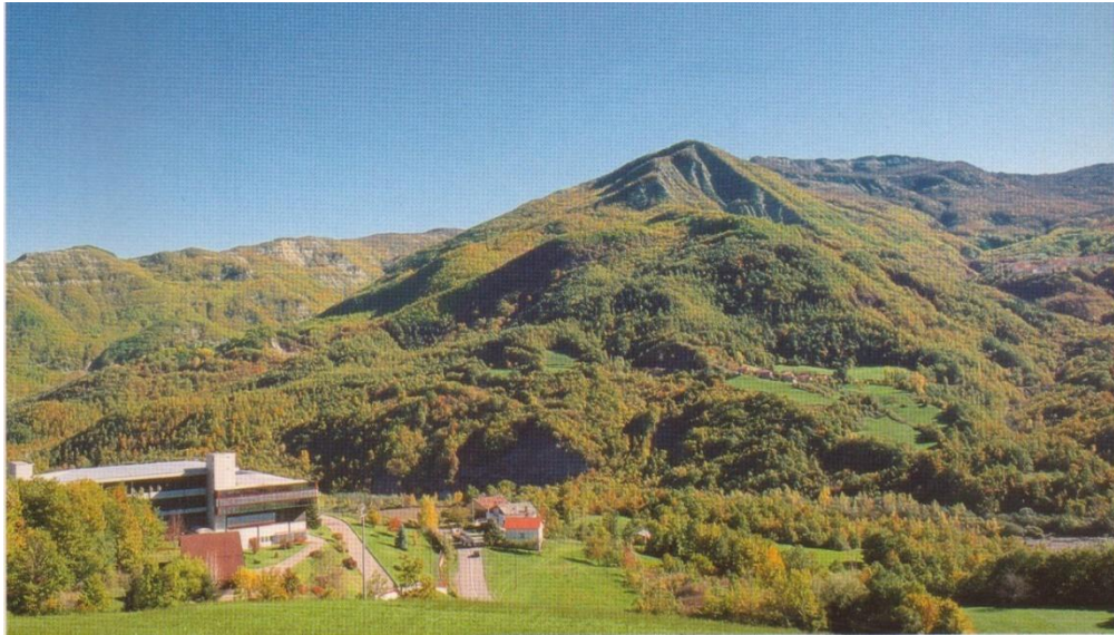
Figura 1 Inserimento del sito nell'ambiente appenninico circostante
